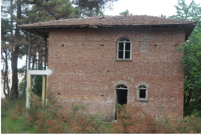
Resim 10: Konakpınar Ortaokulu Doğu Cephe Genel Görünümü (A. Yavuzylmaz, 2015)
