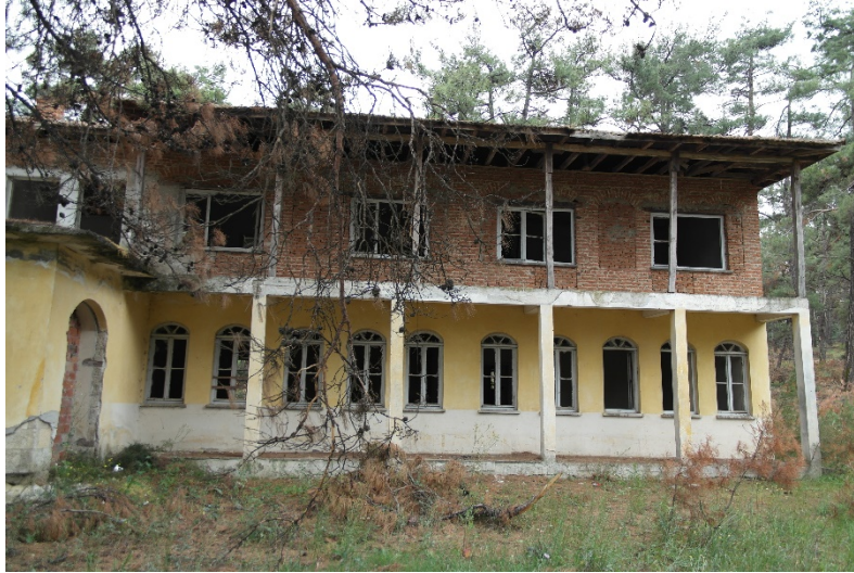
Resim 11: Konakpınar Ortaokulu Güney Cephe Genel Görünümü (A. Yavuzylmaz, 2015)
