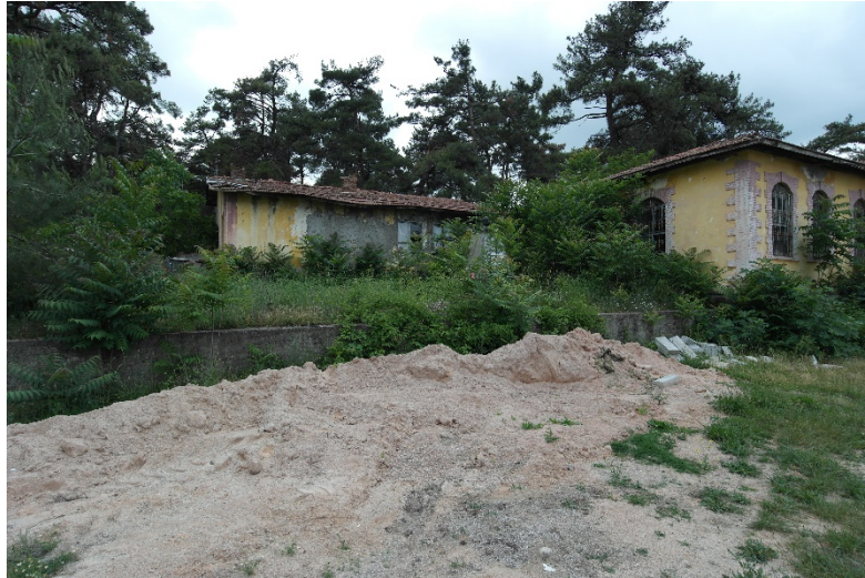
Resim 8. Konakpınar İlkokulu Ek Bina ile Ana Bina Genel Görünümü (A. Yavuzylmaz, 2015)
