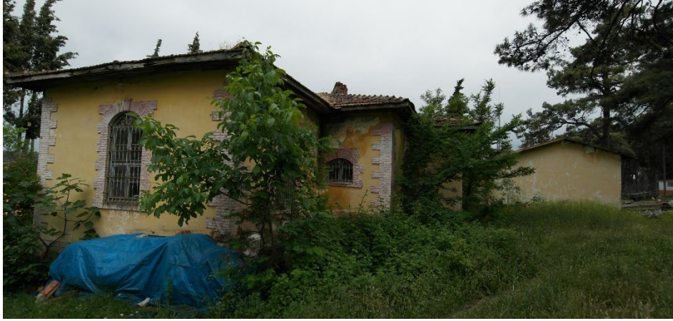
Resim 2. Konakpınar İlkokulu Kuzey Cephesi Genel Görünümü (A. Yavuzylmaz, 2015)
