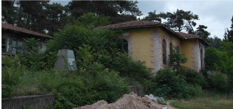
Resim 3. Konakpınar İlkokulu Güney Cephesi Genel Görünümü (A. Yavuzylmaz, 2015)
