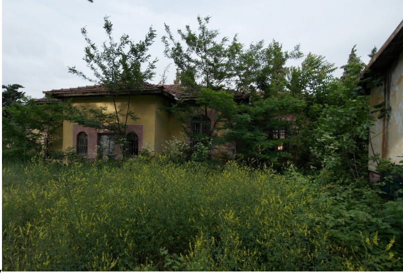
Resim 4. Konakpınar İlkokulu Batı Cephesi Genel Görünümü (A. Yavuzylmaz, 2015)
