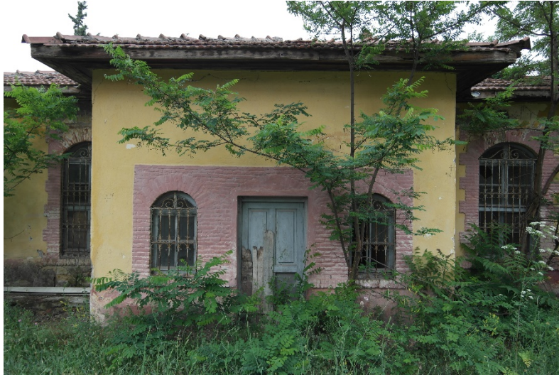
Resim 5. Konakpınar İlkokulu Batı Cephe Merkezi Görünümü (A. Yavuzylmaz, 2015)
