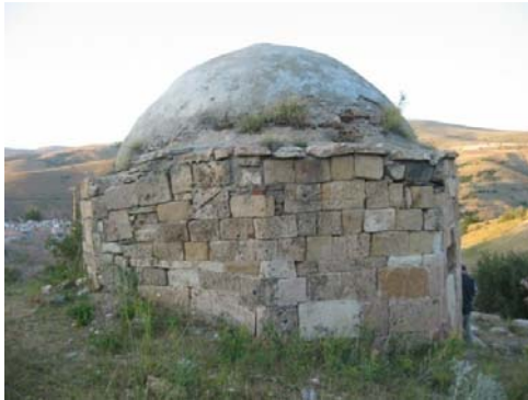
Foto. 15: Çamur Köyü Kümbeti
