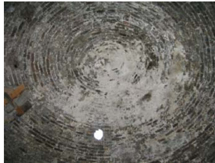
Foto. 16: Çamur Köyü Kümbeti
