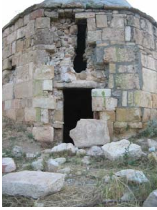
Foto. 17: Çamur Köyü Kümbeti
