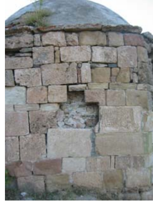
Foto. 18: Çamur Köyü Kümbeti
