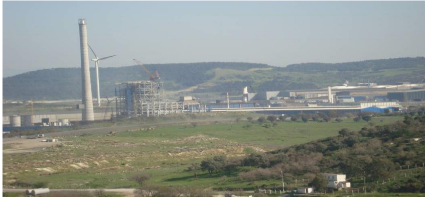
Fotoğraf 4: Aliğa Nemrut Sanayi Bölgesi’nde demir-çelik fabrikalarının ve inşaatı devam eden termik santralin görünüşü.
