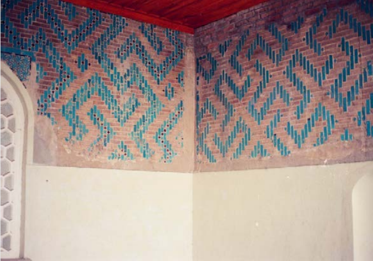
Fotoğraf 12. Eyvan duvarlarındaki sırlı tuğla süsleme
