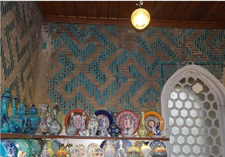
Fotoğraf 13. Duvar yüzeyindeki sırlı tuğla süslemeler
