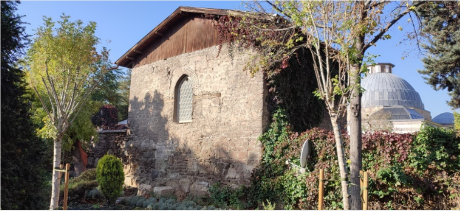
Fotoğraf 5. Eyvanın doğu cephesi
