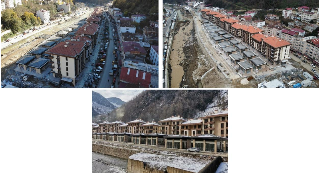
Şekil 12. Taşkından sonra yeniden inşa edilen Dereli ilçesi (URL-7, 2022)
