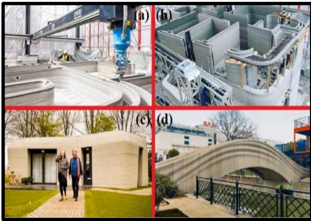
Şekil 2. 3D yazıcı ile beton üretimi ve kullanım alanları (a)Büyük ölçekli 3DCP (Anjuma ve diğ., 2017), (b)PERI/COBOD ve Mense-Korte'de iki katlı bir 3DPC evi, (c)2021'in başlarında Hollanda'nın ilk 3DP evi
