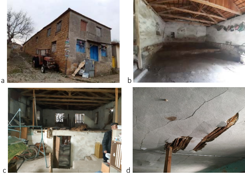
Şekil 7. a. Sinema güney ve batı cephesi b. Sahne c. Aile alanı d. Tavan.
