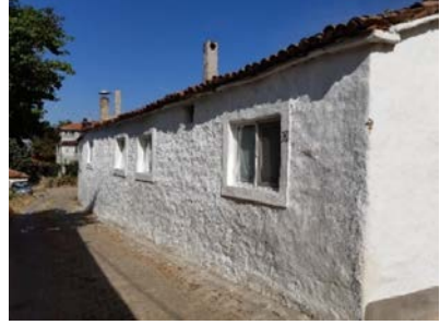
Şekil 14. Cephede sıva ve boya uygulamaları (KTLG-4 ve KTLG-19).
