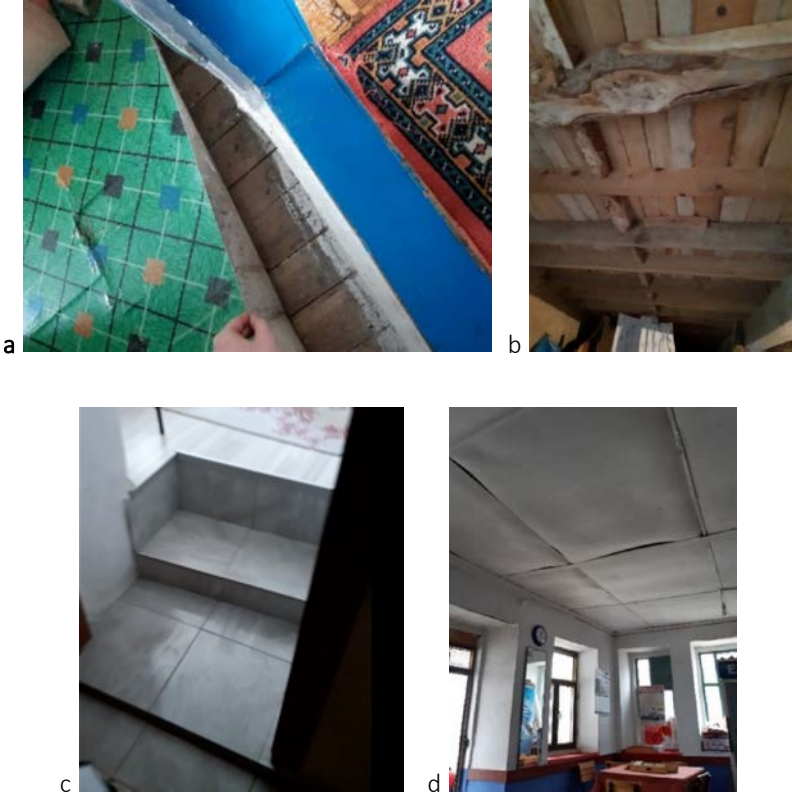
Şekil 17. a. ENV-3 Ahşap döşeme b. ENV-3 Ters tavan c. Muhdes döşeme d. KTLG-3 Kontrplakla kapatılmış tavan.
