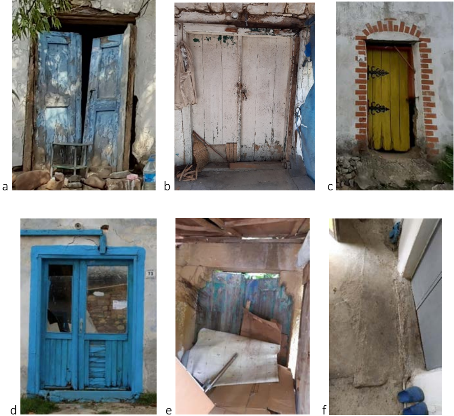
Şekil 19. a. KTLG-22 Çift kanatlı tablalı kapı b. KTLG-17 Çift kanatlı çakma kapı c. KTLG-14 Tek kanatlı depo kapısı d. KTLG-16 Geç dönem çift kanatlı kapı e. ENV-25 Taş süslemeli kapı f. ENV-8 Taş eşik.
