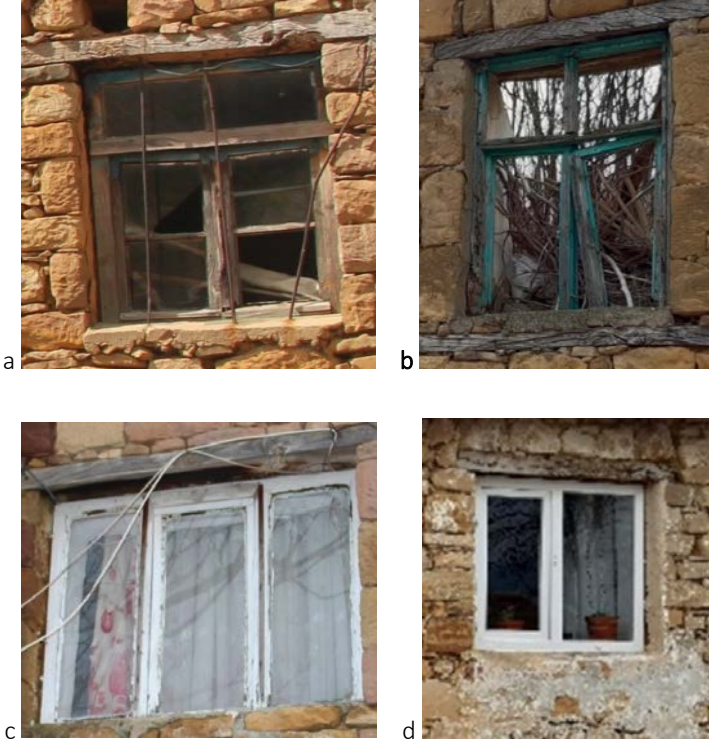
Şekil 21. a-b. KTLG-23, ENV-25 Özgün ahşap pencere c-d. KTLG-5, KTLG-1 Muhdes pencere örnekleri.
