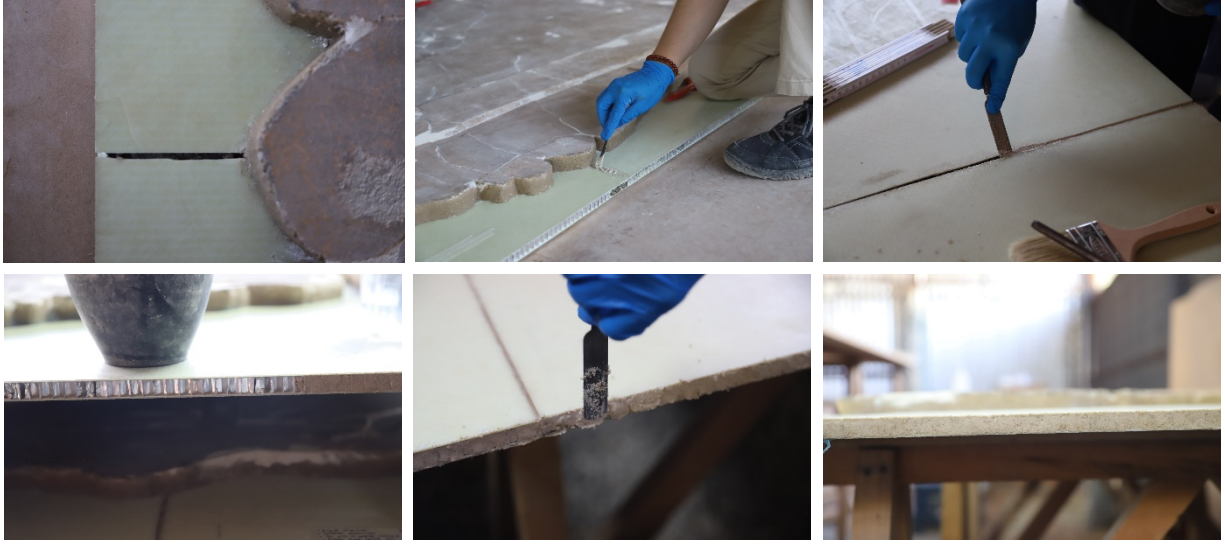
Görsel 13. Taşıyıcı panellerde kenar dolgusu
