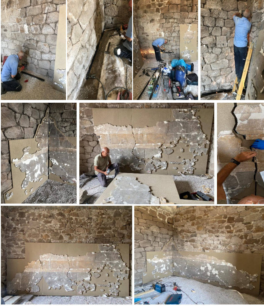
Görsel 16. Duvar resmi panolarının yeniden özgün konumlarına montajı
