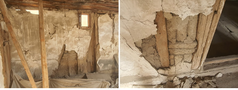
Şekil 9. Handaki ahşap çatıkı arası kerpiç tuğla dolgulu duvar.
