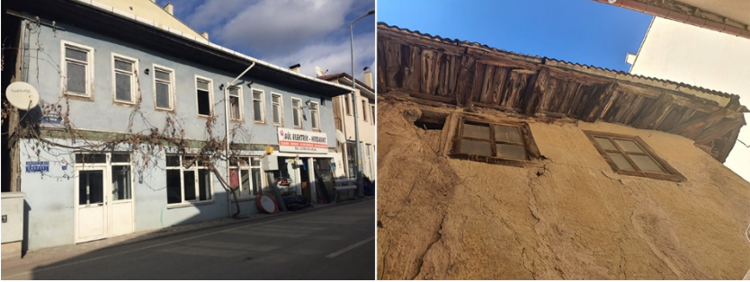
Şekil 8. Hanın güney (ön) ve doğu cephesi görünümü.
