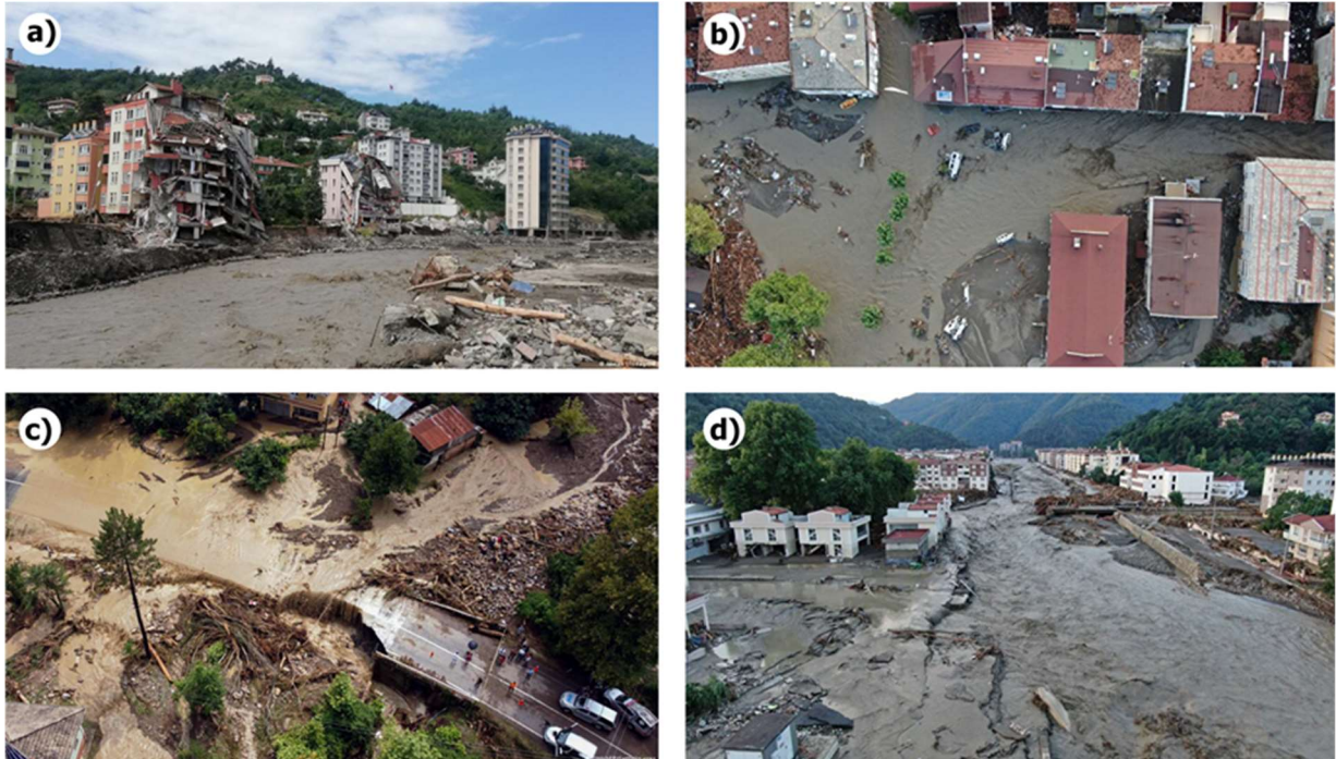
Şekil 2: a-b-c-d) 11 Ağustos 2021, Ezine Çayı'nda meydana gelen taşkın olayının neden olduğu hasar (URL 5-6). Figure 2: a-b-c-d) Damage caused by the flood event on Ezine River on August 11, 2021 (URL 5-6).
