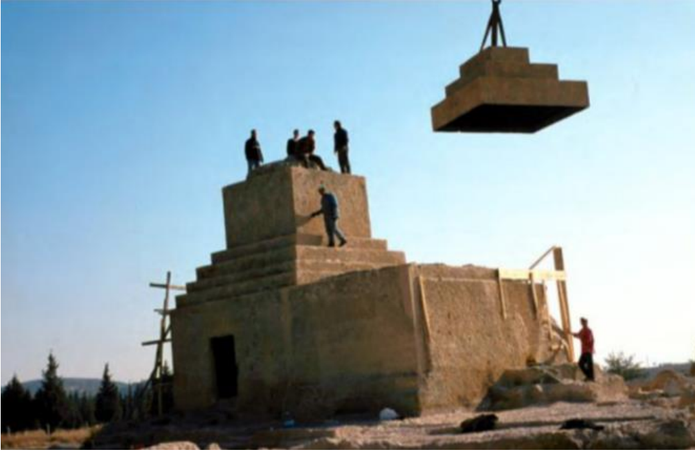
Görsel 4. Polyester Malzemeden Yapılmış Piramidal Üst Çatının Yerine Yerleştirilmesi (Özyiğit, 2012, 300, Resim 8).
