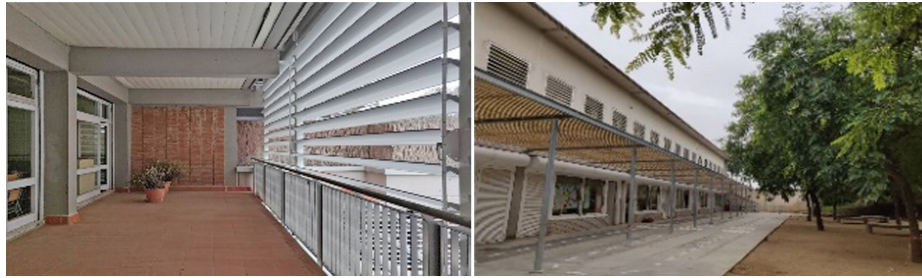
Şekil 8. Poblenu ve Villa Olimpica Okullarında Güneş Kontrolü Elemanları (Soldan Sağa Dođru) (Cartalis, 2021b).
