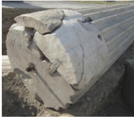
Resim 7. Laodikeia, Sütun Alt Bölümündeki Antik Onarım İzleri 15 (Şimşek, 2017: Fig. 20).
