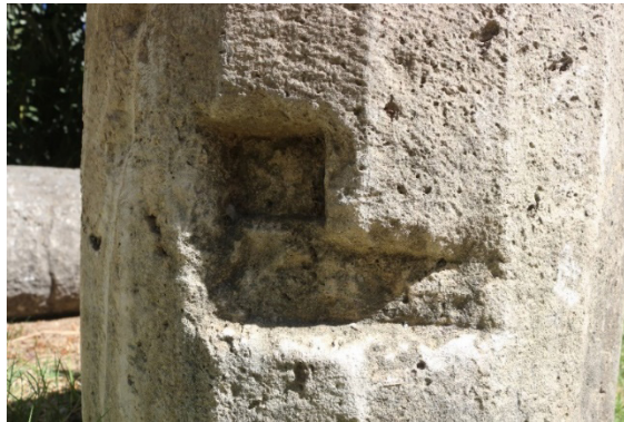
Resim 11. Bej Renkli Kireçtaşı Sütun Tamburunun Antik Onarım Bölümü.
