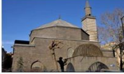
A-Diyarbakır Nebi Cami kubbesi
