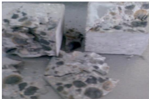
Şekil 7. Sertleşmiş hafif betonun iç görünümü (Interior view of the hardened light weight concrete)
