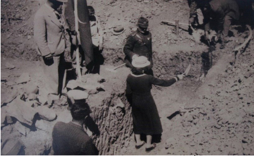
Şekil: 2 Kışla binasının temel atma çalışması, 1935 (Tunceli İl Kültür Müdürlüğü Arşivinden erişilmiştir.)
