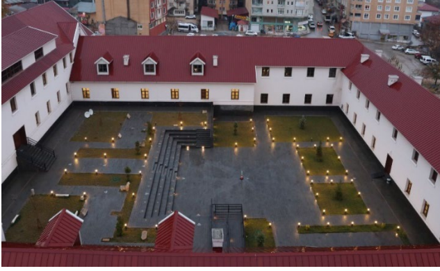
Şekil: 17 Restorasyon projesi kapsamında gerçekleştirilen avlu düzenlemeleri, (URL 3)
