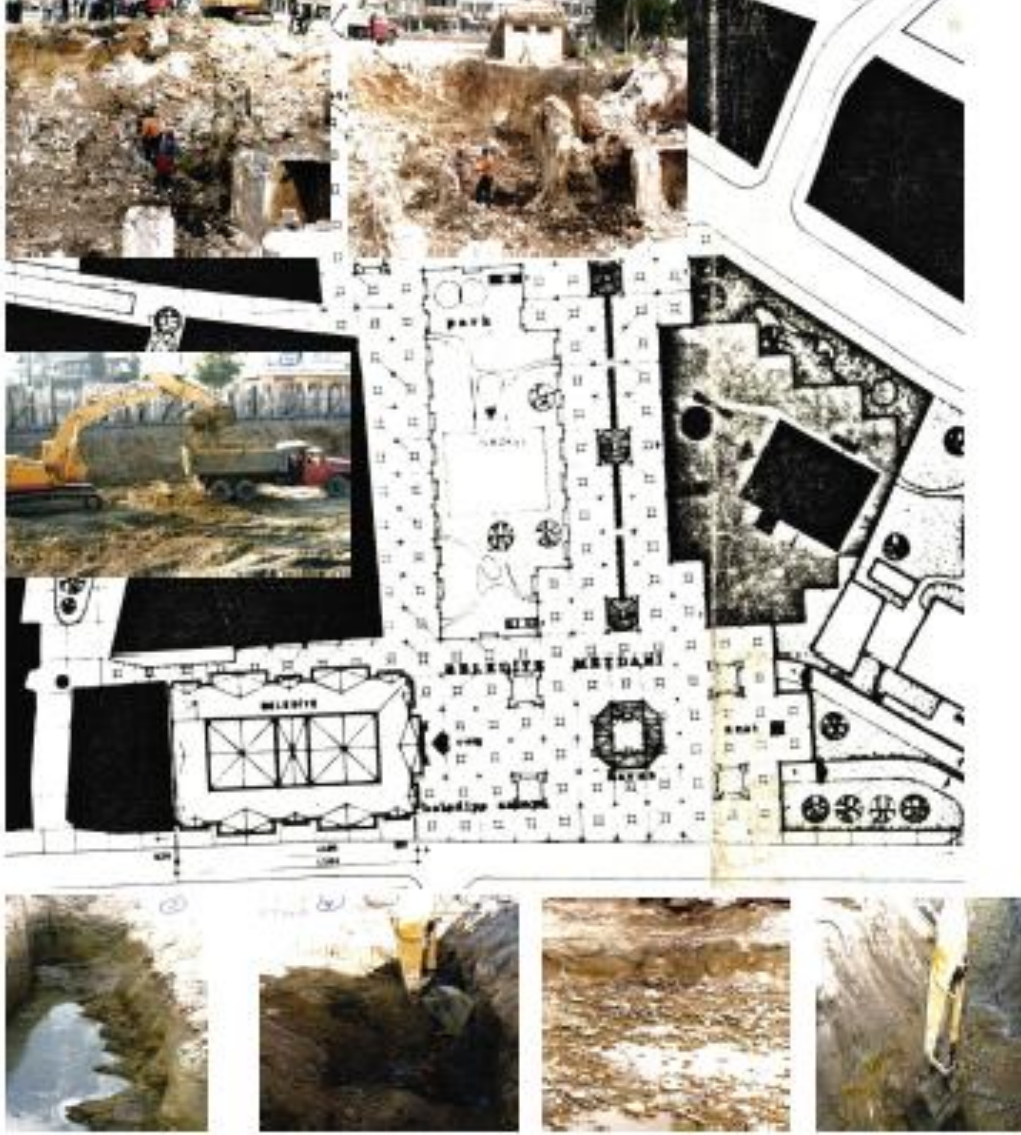
Resim 1. Belediye binası inşaat başlangıcında görünüm (Çorlu belediye arşivi).
