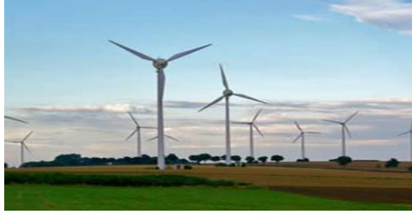
Şekil 7. Kayseri Kurtkaya Rüzgâr Santrali [20]
