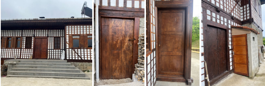
Şekil 9. Evin Batı Cephesinde Bulunan Ana Giriş, Batı Cephesinde Yer Alan Ahır Girişi, Batı Cephesinde Bulunan Misafir Odası Girişi ve Kuzey Cephesinde Yer Alan Depo Girişi-Ek Yapı Tuvalet Girişi
