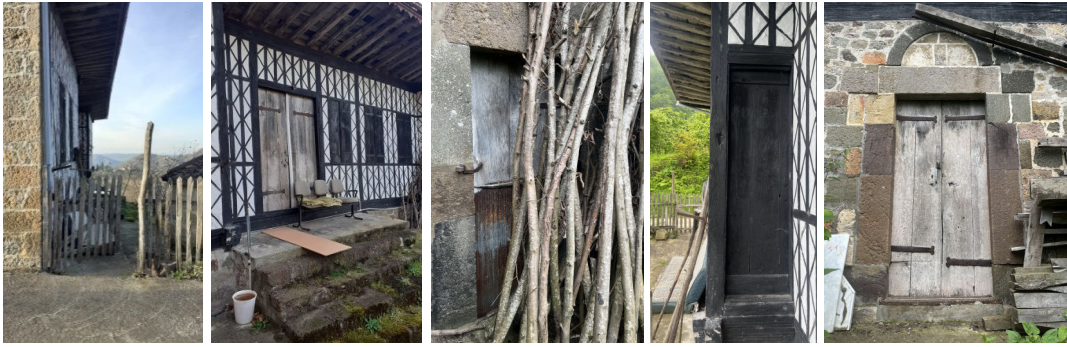
Şekil 21. Doğu Cephesinde Bulunan Ana Girişe Yaklaşım Yolu, Doğu Cephesinde Yer Alan Ana Giriş, Doğu Cephesinde Bulunan Ahır Girişi, Doğu Cephesinde Yer Alan Misafir Odası Girişi ve Kuzey Cephesinde Bulunan Depo Girişi
