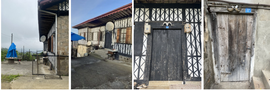
Şekil 20. Evin Batı Cephesinde Bulunan Ana Girişe Yaklaşım Yolu ve Avlu, Batı Cephesinde Bulunan Ana Giriş, Batı Cephesinde Yer Alan Ana Giriş Kapısı-Boğa Boynuzu ve Batı Cephesinde Bulunan Ahır Girişi-Boğa Boynuzu
