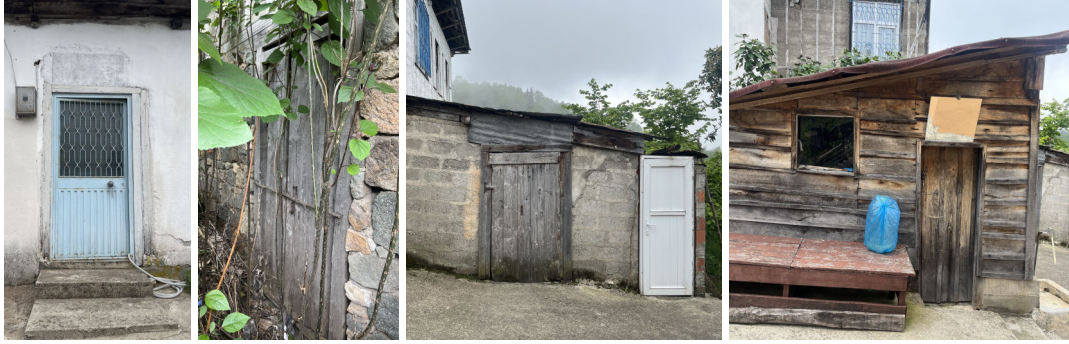
Şekil 24. Evin Doğu Cephesinde Bulunan Ana Giriş, Doğu Cephesinde Yer Alan Ahır Girişi, Eklenti Yapıdaki Ahır-Tuvalet Girişi ve Atölye/Depo Girişi
