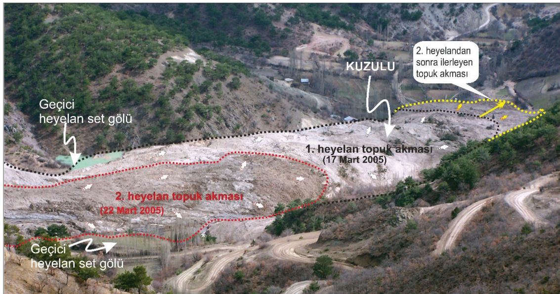
Şekil 9. Kuzulu Heyelanının 1. ve 2. Moloz akmalarının vadi içerisindeki alansal yayılımı ve oluşan geçici iki heyelan set gölünün görünümü
