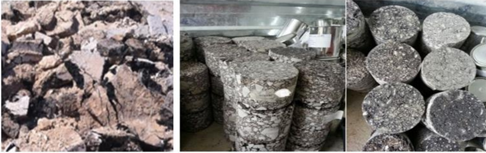
Şekil 2. Hatalı imalat nedeni ile sökülün bitümlü temel tabakası ve alınan karot numuneleri
