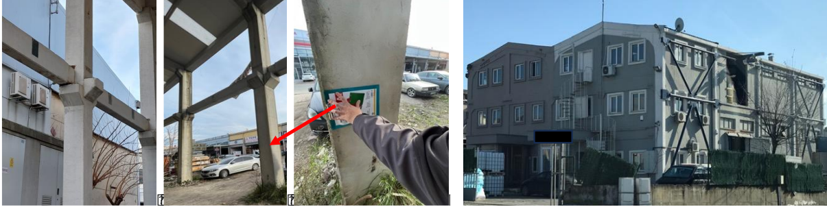
Şekil 2. İstanbul'daki fabrikalar için yapılan teknik geziler sırasında çekilen inşaat aşamasında prekast betonarme tipik bir endüstriyel bina yapısı (solda) ile güçlendirme yapılmış bir endüstriyel bina yapısı (sağda).
