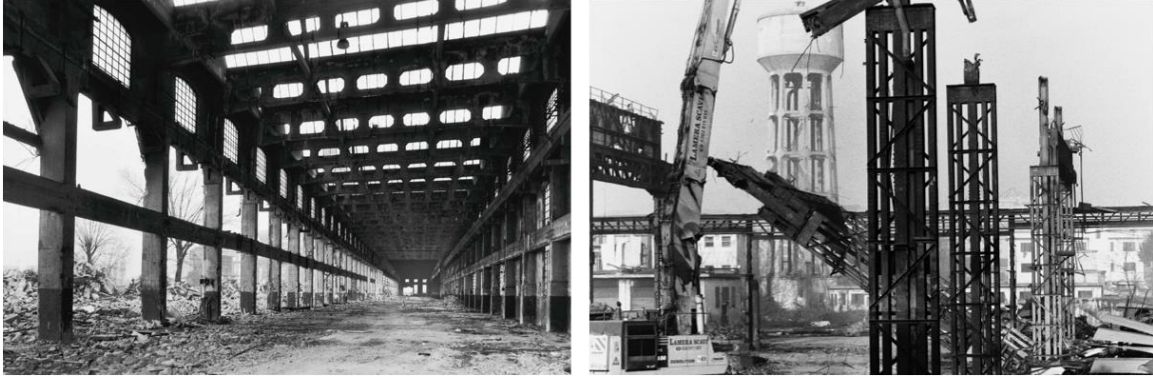
Resim 2: Eski Falck Çelik Fabrikası Tesisleri [1]
