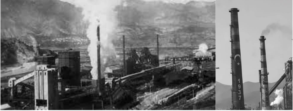
Resim 7: Karabük Demir-Çelik Fabrikası
