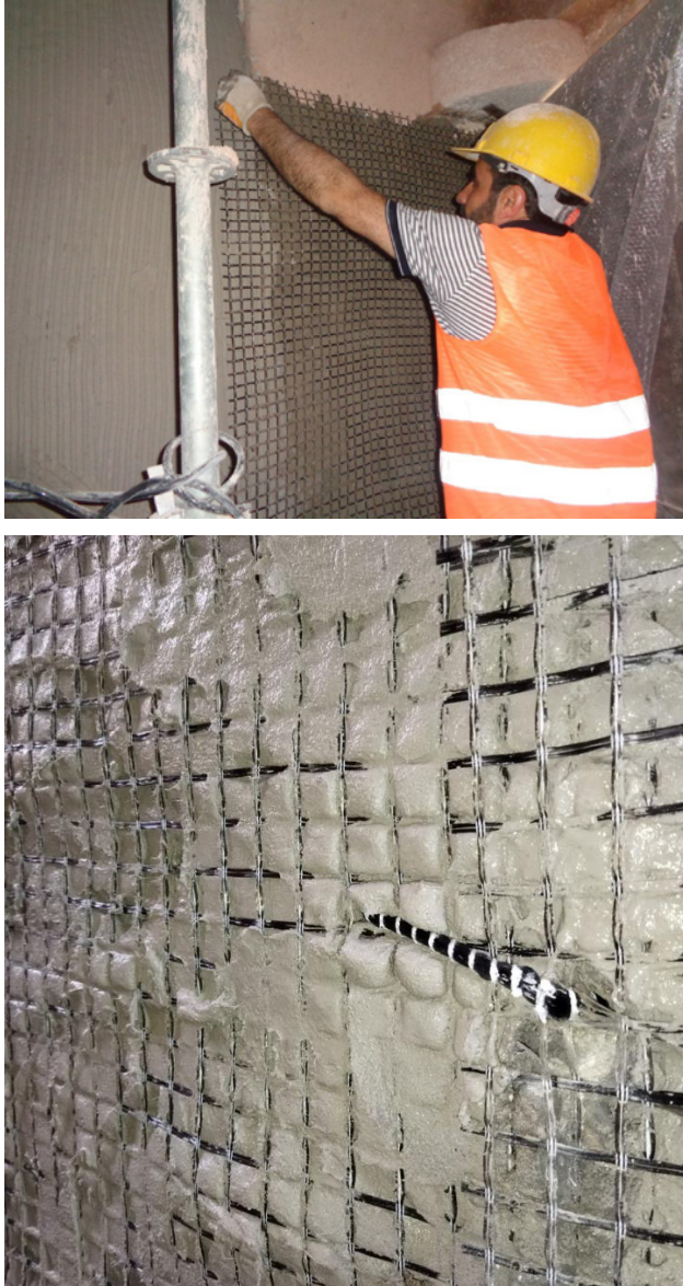
Şekil 13. Tekstil donatılı sıva güçlendirme uygulaması
