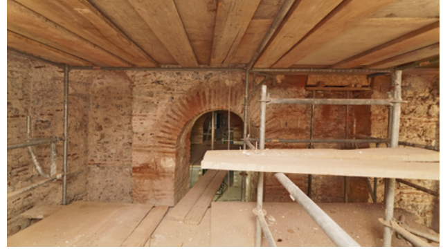
Şekil 20. Betonarme bölümlerin alımı, öncesi-sonrası 38
