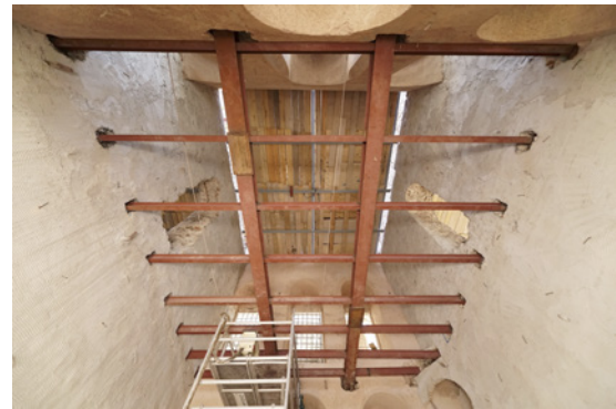
Şekil 19. Ara kat çelik uygulaması 35
