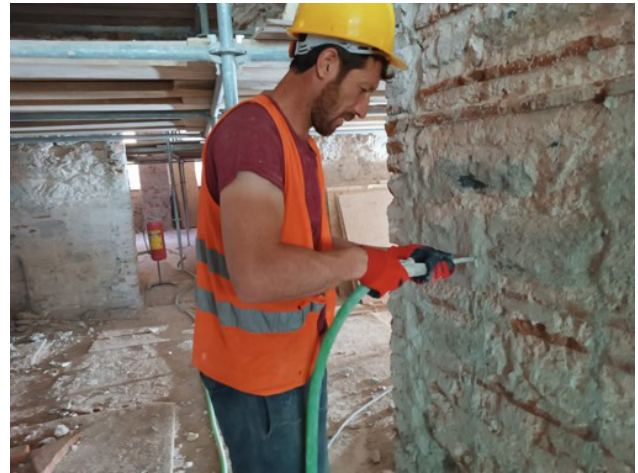
Şekil 11. Enjeksiyon uygulama süreçleri (delik açılması, hortum yerleştirilmesi, enjeksiyon basılması)
