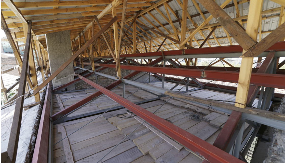
Şekil 17. Çelik çatı güçlendirme uygulaması 32
