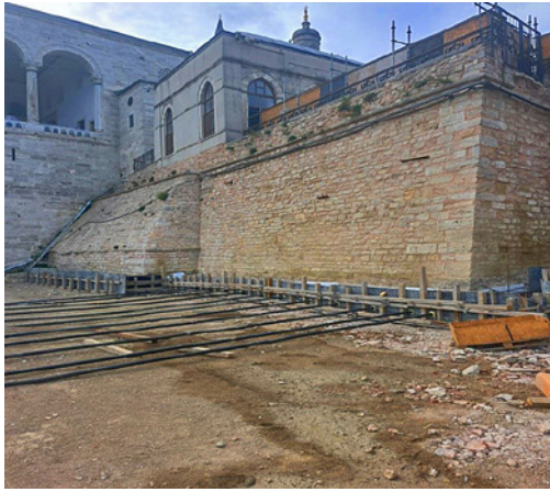
Resim 11-12. Mecidiye Köşkü'nün alt bahçesinde mini kazık ve tie rod çalışmaları (Eril, 2022, 2023)
