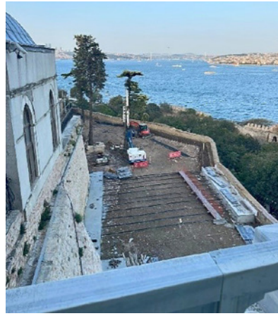
Resim 11-12. Mecidiye Köşkü'nün alt bahçesinde mini kazık ve tie rod çalışmaları (Eril, 2022, 2023)
