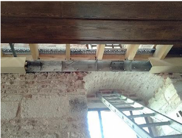
Şekil 5. Döşemenin taşıyıcı duvarla olan birleşim detayı
