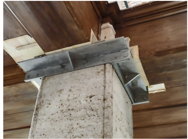
Şekil 6. Döşemenin taşıyıcı taş sütunlarla olan birleşim detayı
