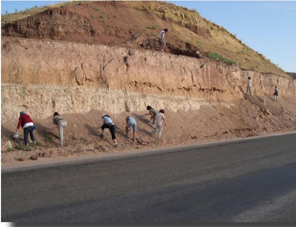
Resim 1. Çorakyerler yol yarması çalışmaları
