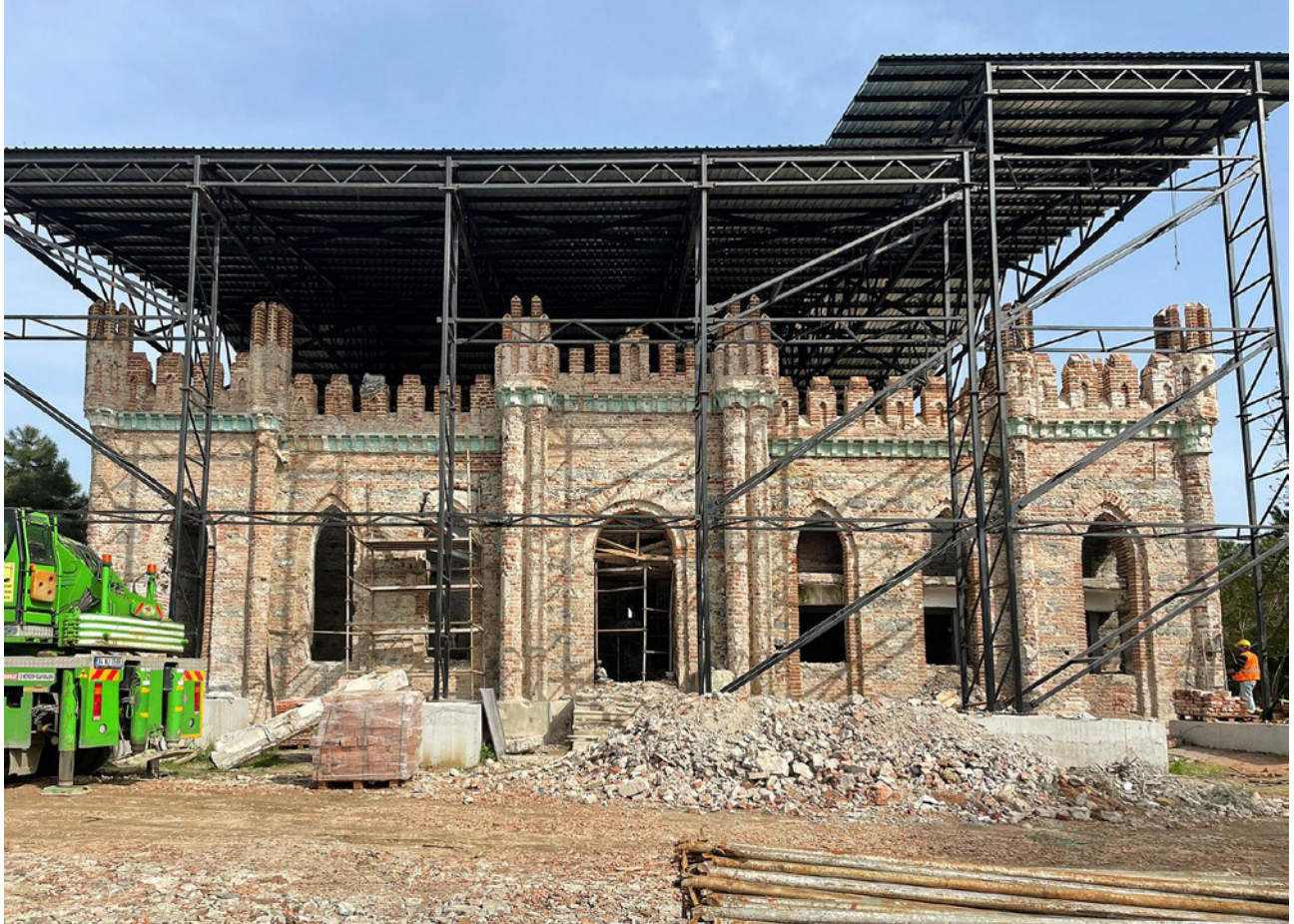
10 Geçici çatı ve raspa çalışmaları
