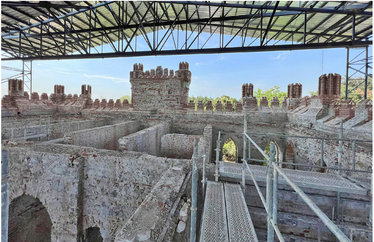
14 Betonarme çatı tabliyesinin kesilerek uzaklaştırılması
