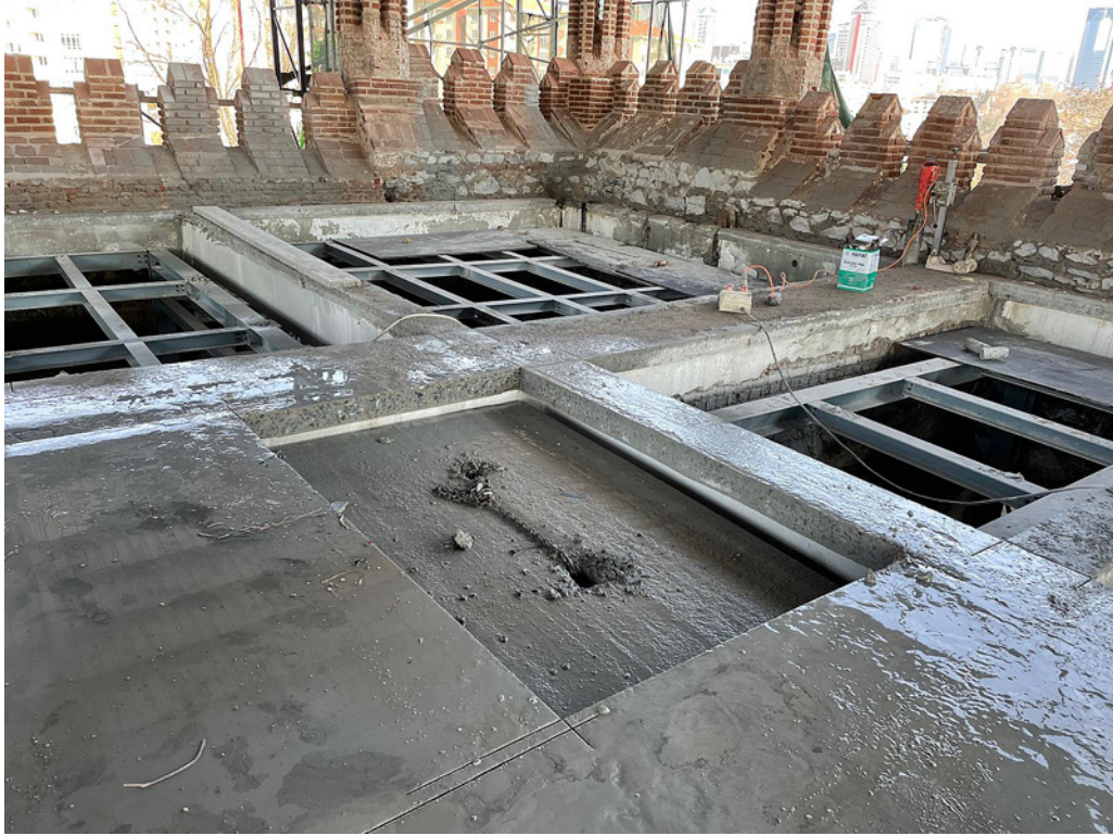
13 Betonarme çatı tabliyesinin kesilerek uzaklaştırılması
