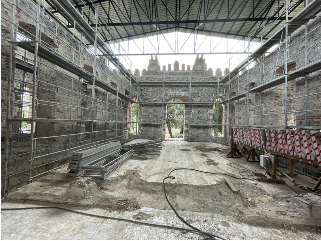
15 Betonarme atı tabliyesinin kesilerek uzaklařtırılması
