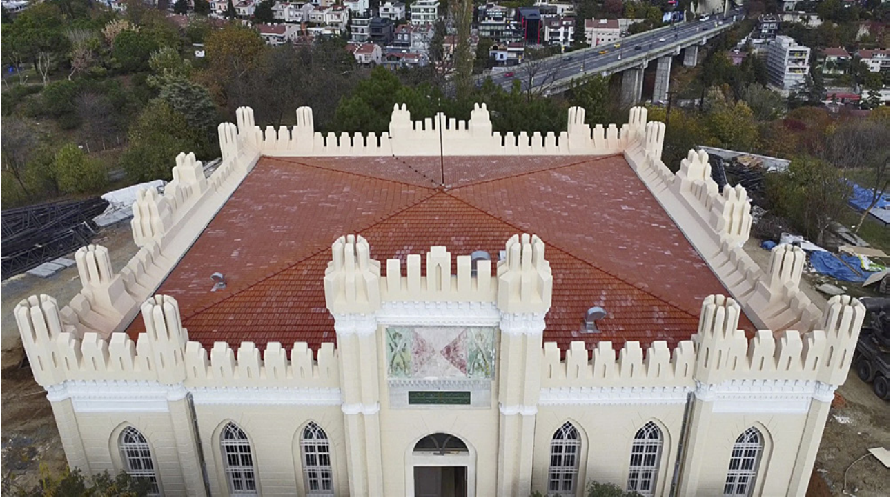
20 Restorasyon sonrası genel görünüm
