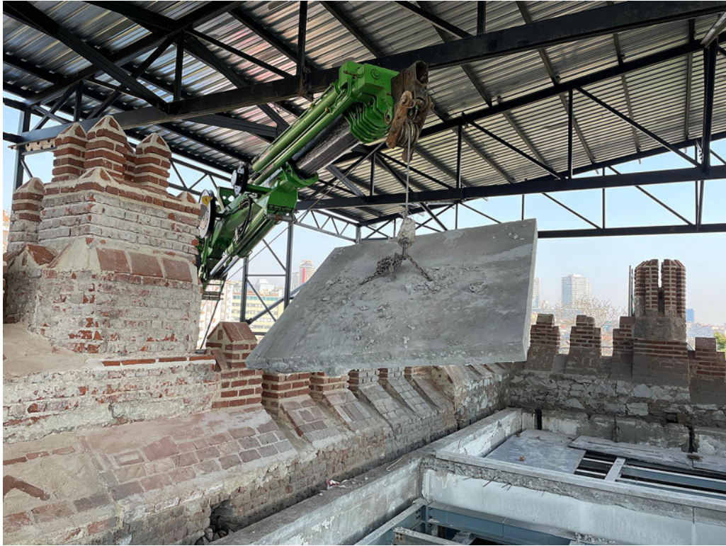
12 Betonarme atı tabliyesinin kesilerek uzaklařtırılması
