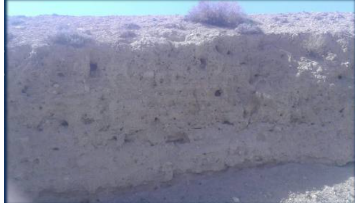
Resim 6: Tarihi kaynaklara göre Chih-chih Ch'an-yü'nün kale şehri olduğu düşünülen Kulan Koruk Yerleşim Yerinin Duvar Temeli.
