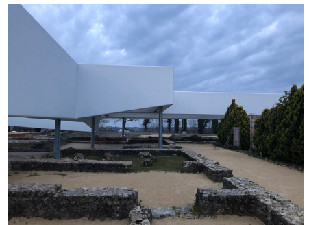
Figure 18 Villa gallo romaine de Séviac - France. Conservation et restauration des mosaïques. Réalisation de la nouvelle couverture (vue détaillée) (Perpignani 2019: 229).
