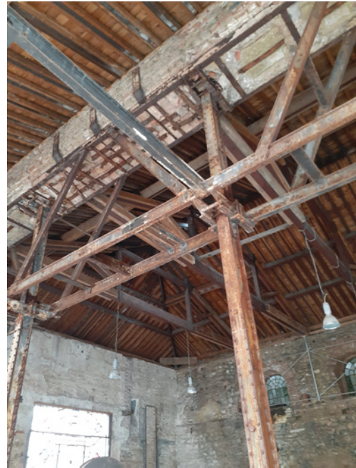
Şekil 12. Sonradan açılan açıklık ve çelik profiller
