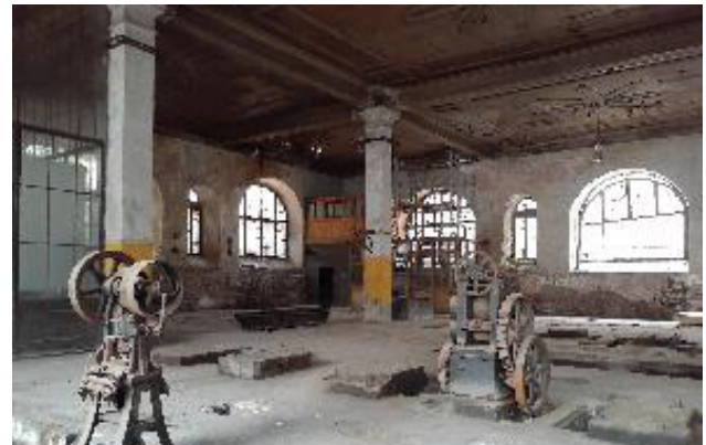
Şekil 4. Almasıık duvar örgüsü, taş ayaklar ve özgün tavan kaplaması
