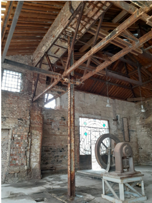
Şekil 12. Sonradan açılan açıklık ve çelik profiller
