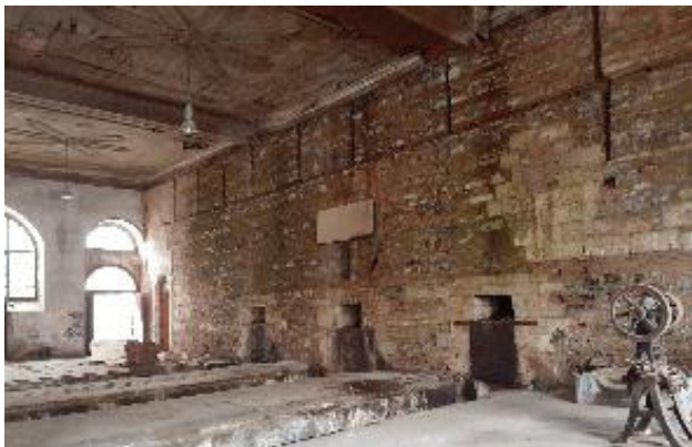
Şekil 4. Almasıık duvar örgüsü, taş ayaklar ve özgün tavan kaplaması
