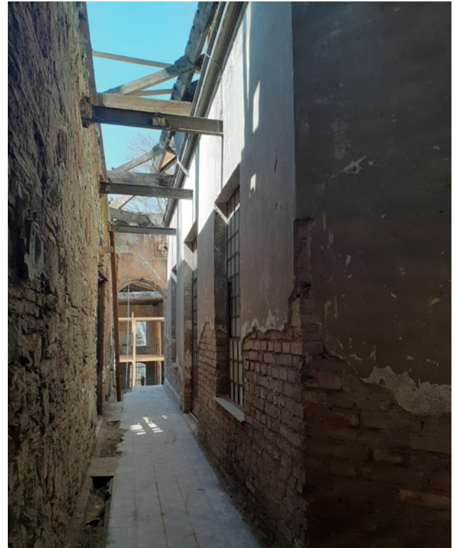
Şekil 32. Pantograf Mahalli, uygulama öncesinde duvar dokusu ve çatı sökümünden görünüm
