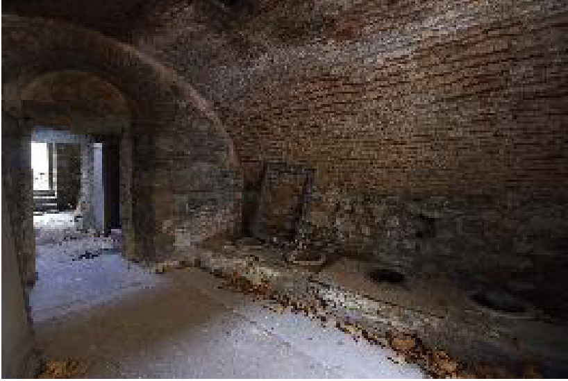
Şekil 33. Yağ depoları tonoz örtüsü
