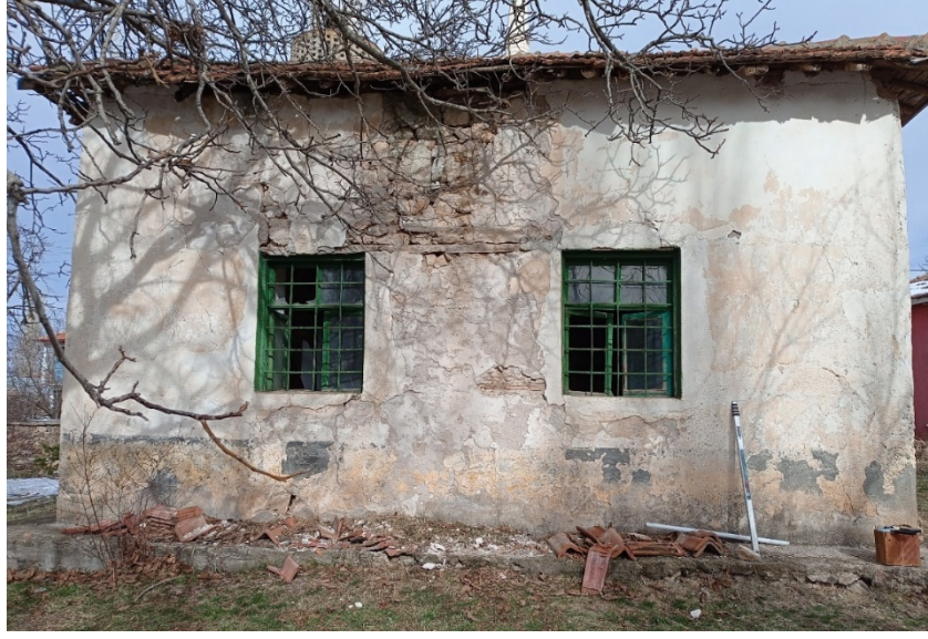
Fig. 8. Güney Cephe (Demir Group Arşivi)
