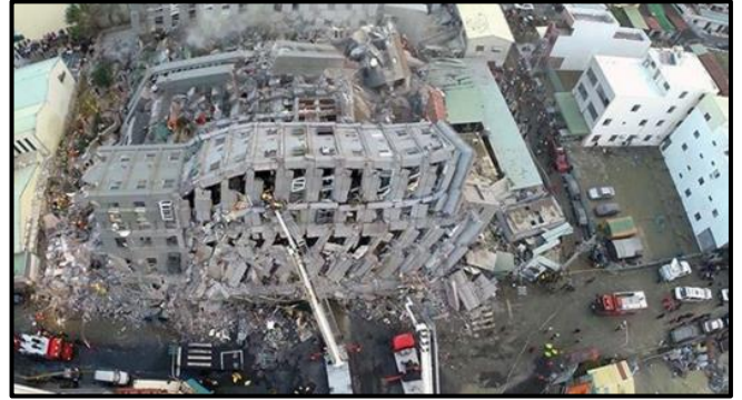
Şekil 4. Kocaeli (1999) depreminde meydana gelen yıkım (URL-2, 2023)
