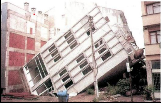
Şekil 14. Adapazarı'nda sıvılaşma nedeniyle oluşan taşıma gücü kaybı ve farklı oturma nedeniyle devrilen yapı (Altındış, 2020)
