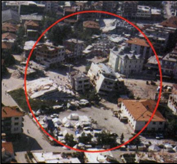
Şekil 8. Adapazarı depreminde meydana gelen zemin yükü oturma örneği (Ulusay, 2000)
