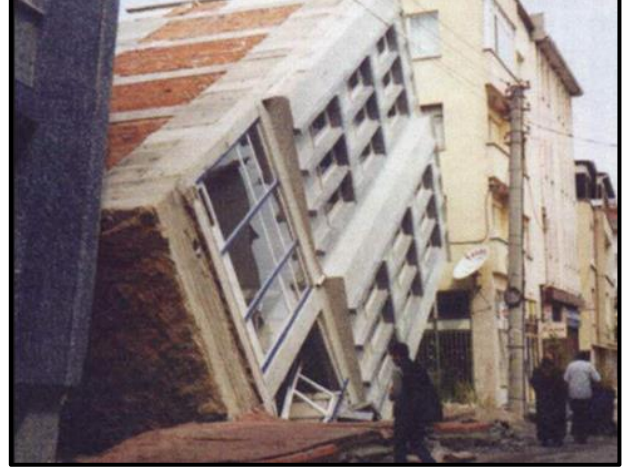
Şekil 9. Adapazarı'nda sıvılaşma nedeniyle devrilmiş bina (Ulusay, 2000)
