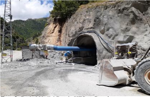
Foto 3: Barhal Vadisi Damla HES ve Regülatörü inşaat alanı (27.07.2022)
