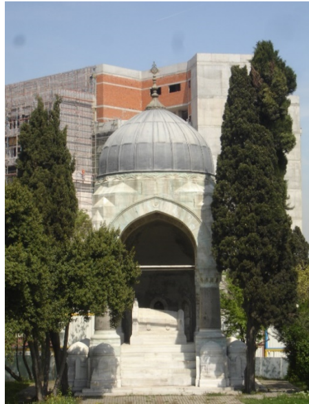
Fotograf 8. Mahmut Şevket Paşa Türbesi Genel Görünüş (M. Bulut,2013)
