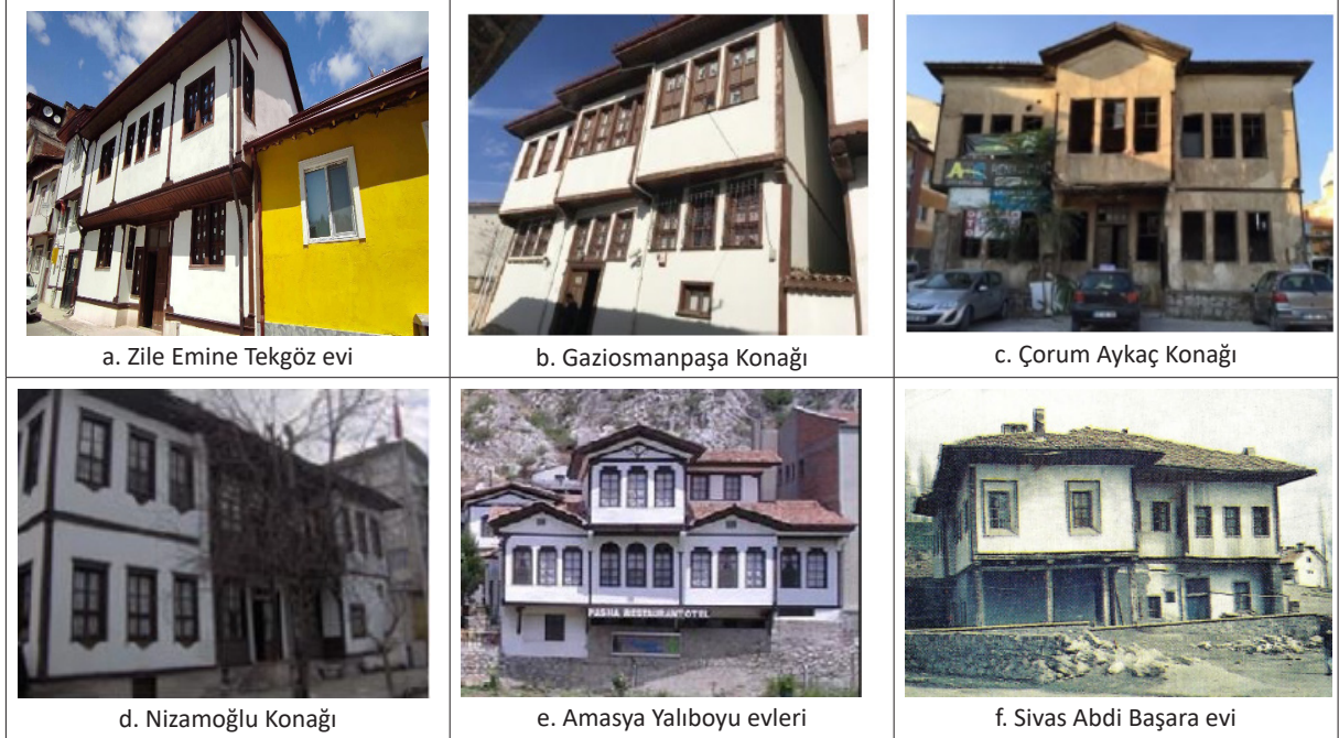
Şekil 29: Alt katları kesme taştan, üst katları ahşap çatkı arası kerpiç dolgulu olan evler
