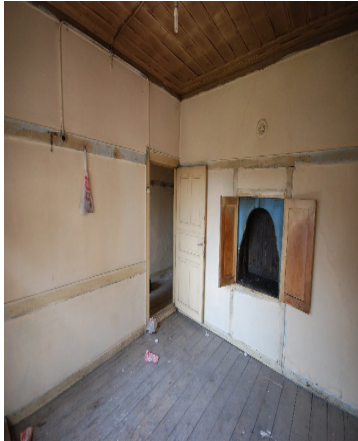
İç mekân oda kapılarının görünüşü
