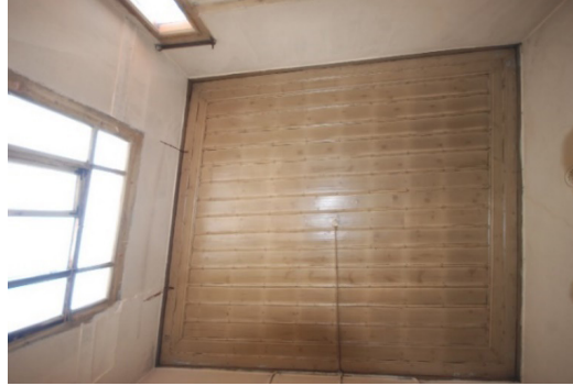
Şekil 23: Ahşap çitallı düz tavan görünüşü
