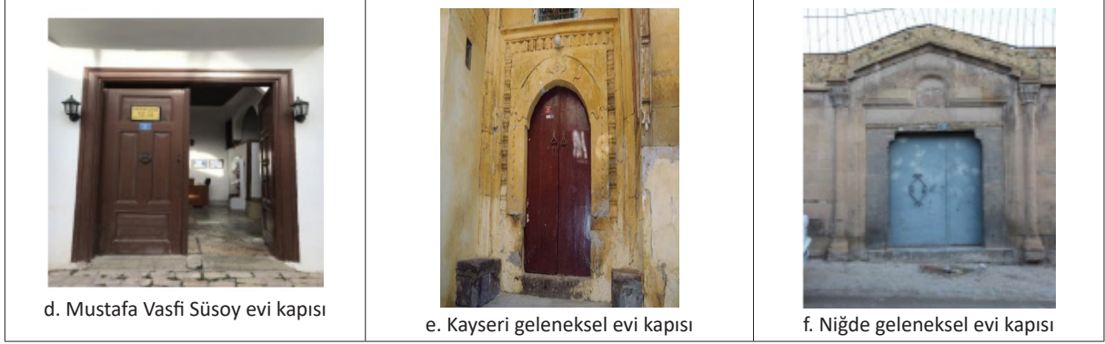
Şekil 33: Ahşaptan yapılmış çift kanatlı giriş kapıları
