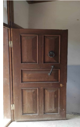
İç mekân oda kapılarının görünüşü
