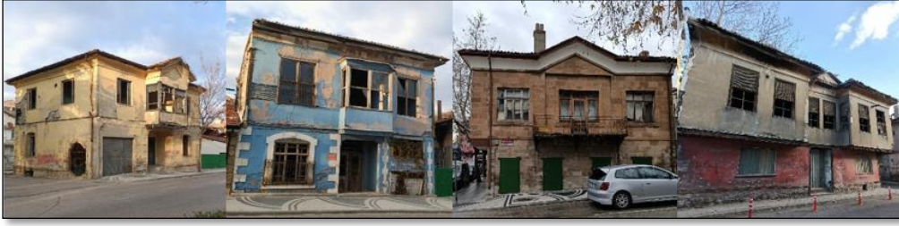
Şekil 5. Isparta kent merkezinde bulunan bazı tescilli yapı örnekleri Figure 5. Examples of some registered buildings in Isparta city center
