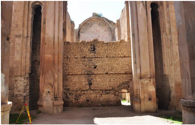
Şekil 5. Işhan Kilisesi, batı haç kolunu ayıran geç dönem duvarına bakış (Erzurum Bölge Koruma Kurulu arşivi)
