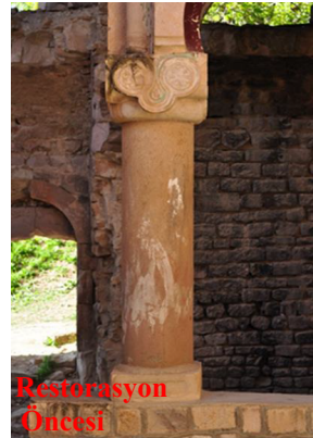
Şekil 14. İshhan Kilisesi apsis arka duvarı is kaynaklı yüzey kirliliği (restorasyon öncesi fotoğraflar Erzurum Bölge Koruma Kurulu Arşivine aittir)
