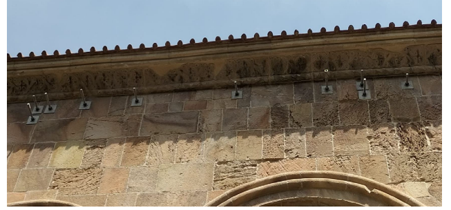
Şekil 20. İshhan Kilisesi restorasyon sonrası üst örtü
