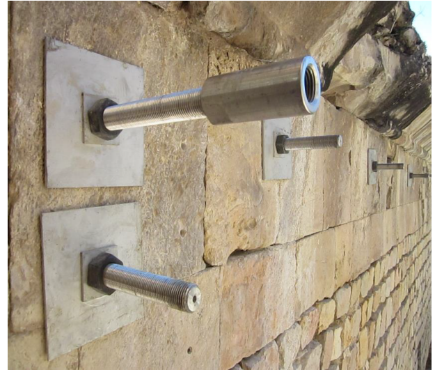
Şekil 18. İshân Kilisesi gergi çubuğu uygulama sonrası
