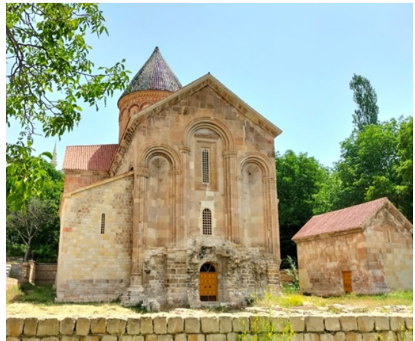
Şekil 2. İşhan Kilisesi restorasyon sonrası kuzey cephesi
