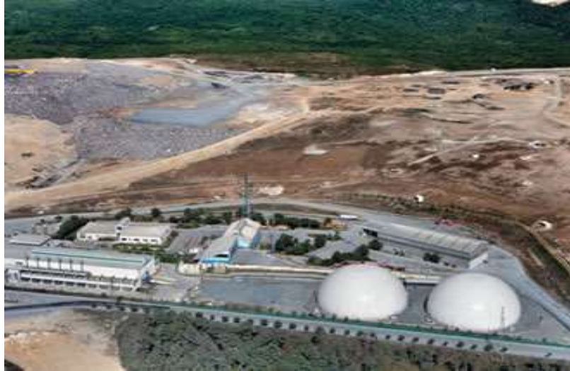
Şekil 2. Odayeri çöp gazı santralinden bir görüntü [14] (Figure 2. Image from a plant odayeri landfill gas)
