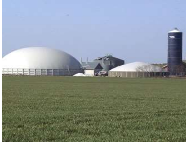
Şekil 3. Mamak çöplüğü biyogaz tesisi santralinden bir görüntü [14] Figure 3. Mamak landfill biogas plant plant from an image
