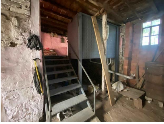
Şekil 7. Özgün Ahşap Merdivenin Üstüne Yapılan Demir Merdiven [9]
