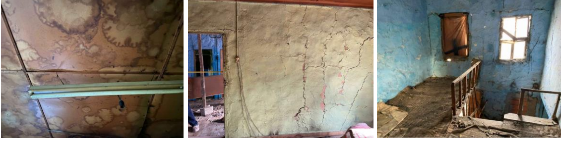
Şekil 23. Atmosferik Hava Koşulları ve Bakımsızlıktan oluşan Bozulmalar [11]
