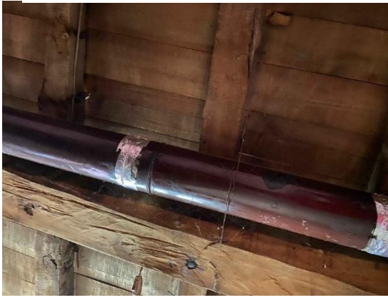
Şekil 8. Soba Bacası Kirişe Paralel Durumu ve Baca Boşluğu [9]
