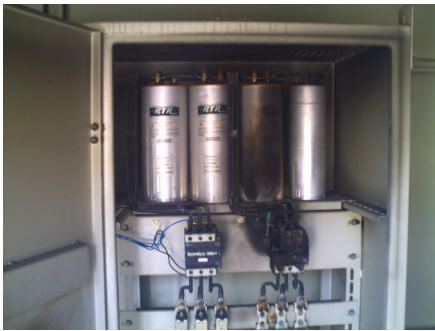
Resim 3. KALABA ŞELELE ABONELİĞİNE AIT KOMPAZASYON PANOSUNUN REVİZE EDİLMEYEN ÖNCEKİ HALİ
