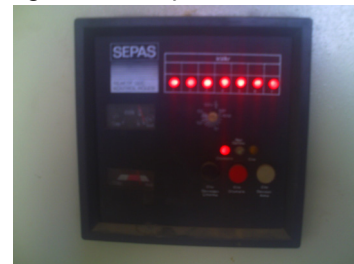
Resim 1. TEK FAZ KONTROLLÜ REAKTİF GÜÇ KONTROL RÖLESİ
