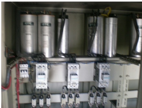
Resim 4. KALABA ŞELELE ABONELİĞİNE AIT KOMPAZASYON PANOSUNUN REVİZE EDİLDİKTEN SONRAKİ HALİ
