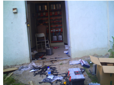
Resim 7. HİZMET BİNASI ABONELİĞİNE AIT KOMPAZASYON PANOSUNDA REAKTİF GÜÇ RÖLESİ VE KONDANSATÖR DEĞİŞİMİ YAPILIYOR
