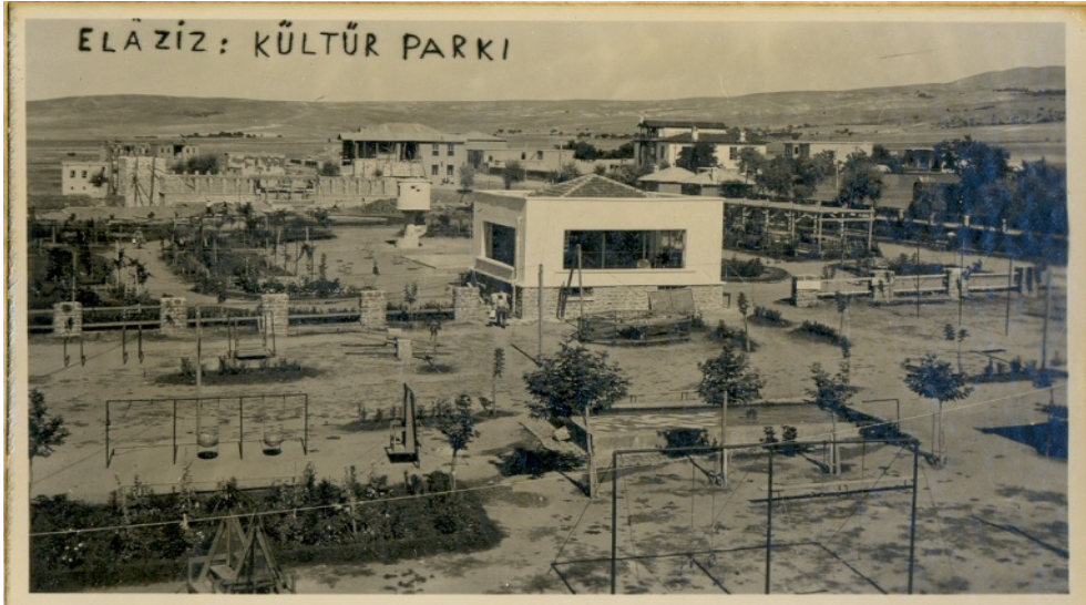
Foto 8. Tevfik Sırrı Gür zamanında yapımı tamamlanan Elâzığ Kültür Parkı
