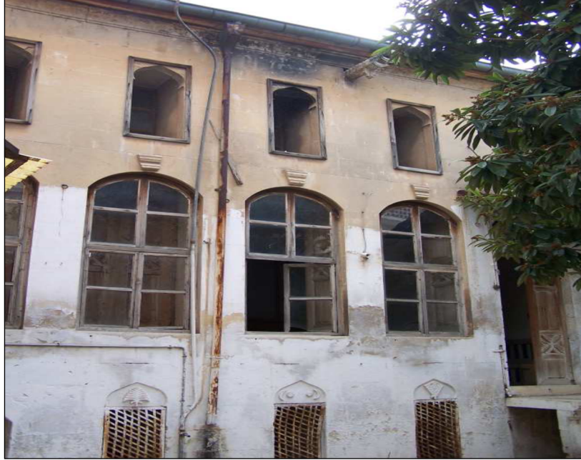
Foto 5. Kuş Pencereleri: Kilis evleri normal pencereler yanında odanın yüksek kısmına açılmış küçük boyutlardaki "kuş penceresi" adı verilen yapılara sahipti. Bu pencereler havalandırma özelliği görmekteydi.
