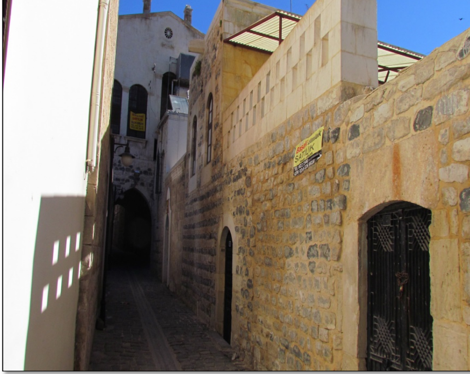
Foto 1. Kilis Evlerinde Yapı Taşları: Kilis evlerinde kullanılan en yaygın malzeme taştır. Kireç taşı ve marndan oluşan yapı malzemesi çabuk işlenebilir özellik taşımaktadır. Özellikle kışık odaların duvarlarının kalın yapılması söz konusudur. Ayrıca bu yapı malzemesinin odaları kışın sıcak, yazın ise serin tuttuğu söylenmektedir.
