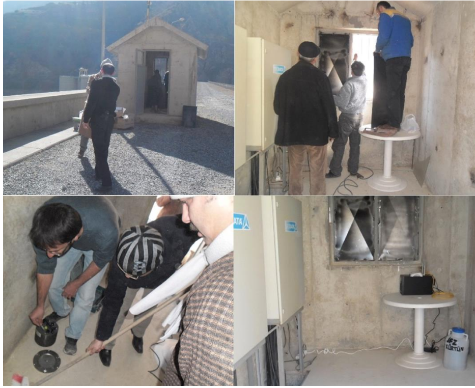
Şekil 4. Kürtün HES ivme kayıt istasyonunun kurulumu.
