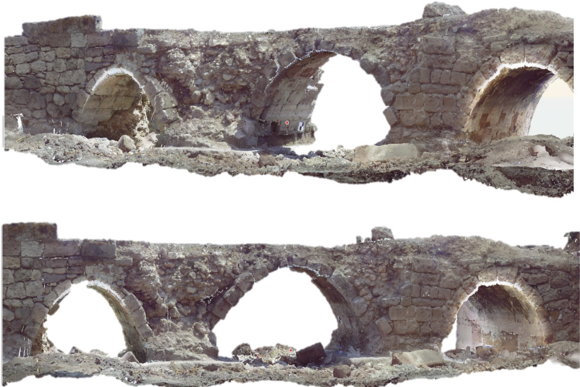
Şekil 4. Köprünün alt kısımlarının detaylı 3B nokta bulutu.
