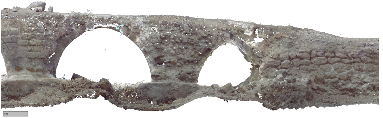
Şekil 6. Yapıya ait bir cephesinin ortofotosu.
