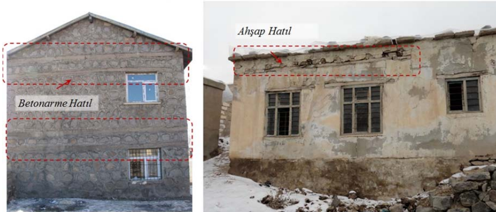
Şekil 11. Hatıl sistemleri.
