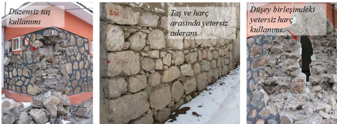
Şekil 6. Taş yığma yapılarda düzlem dışı davranış.
