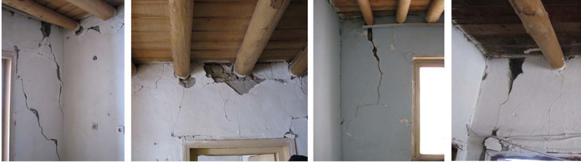
Şekil 13. Çatının doğrudan taşıyıcı duvara oturması.
