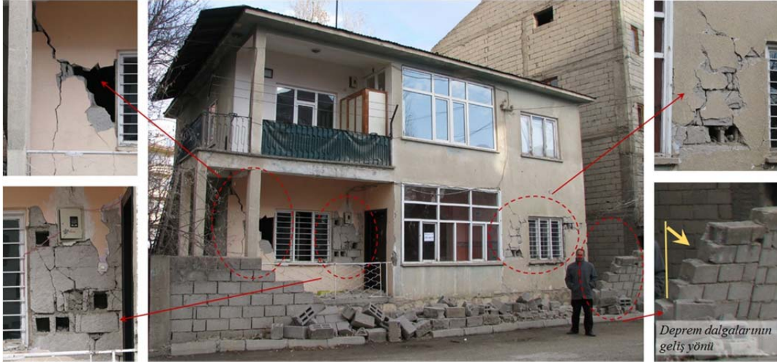
Şekil 24. Düzlem dışı ve düzlem içi davranışın birlikte gözlenmesi.
