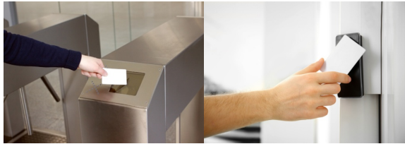
Figure 2. Card Access System (Kartlı Geçiş Sistemi)
