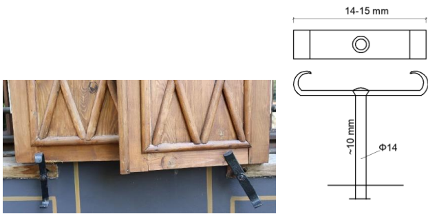
Fig. 29. Shutter holder in Argir Kuyumcuoğlu house (Şahin H. 2021).
