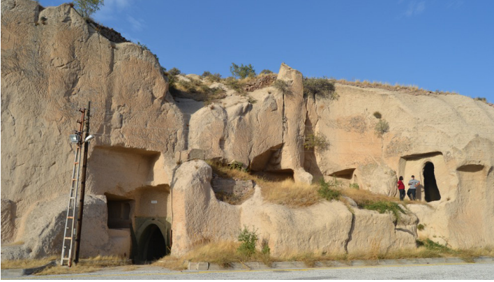
Fot. 11: Akmanastır kompleksi, güneyden kuzeydoğuya bakış (N. Ataç, 2019)
