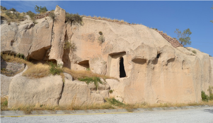
Fot. 30: Akmanastır Şapeli No. 1, cephe (N. Ataç, 2019)
