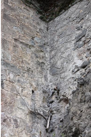
Res. 16: Kanuni Devri-Eski Duvar Dilatasyonu
